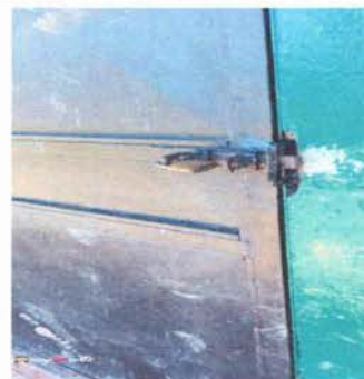
Foto 2: se observa el deterioro de la puerta
